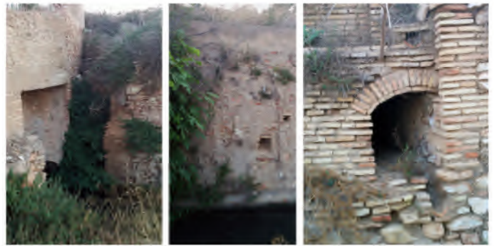
Fig. 5. Tres imágenes de detalle del muro contención del terraplén existente sobre el tramo abierto de la acequia.
