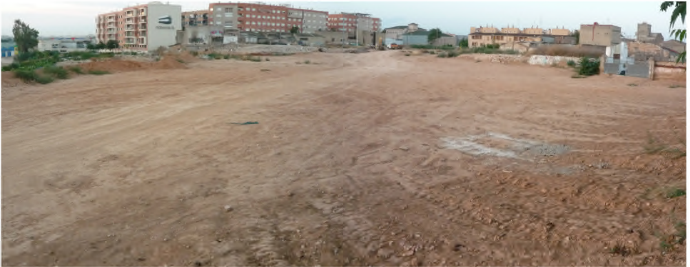
Fig. 1. Imagen del Barri d'Obradors de Manises tomada el 18 de agosto de 2010, pocas horas después de la última demolición.
