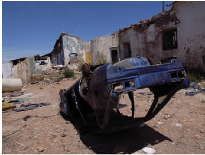
Fig. 7. Dos imágenes de los años 2008 y 2010, que ilustran la degradación y las demoliciones.
