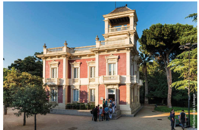
Fig. 1. Exterior del Museo Can Tinturé ©MEL. Archivo Fotográfico. Fot.: Turismo Baix Llobregat
