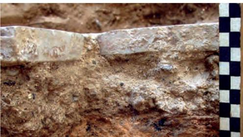
Fig. 3. Detalle del sistema de colocación y puesta en obra de un pavimento de finales del siglo XV, obsérvese la función de los lados oblicuos de los azulejos.
