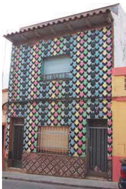
Fig. 7. Vivienda de la Calle San Fermín, nº 7, Onda, 1950 c (V. Estall, 2017).
