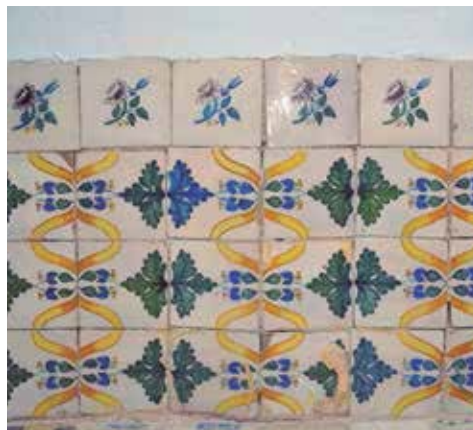
Fig. 27. Zócalo de la capilla San José, 1830-60 (V. Estall, 2000).
