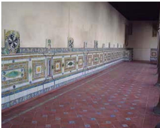
Fig. 17. Imagen de la crujía sur tras la restauración, restituidos los arrimaderos y el suelo con las olambrillas y encintados. Al fondo, el hueco cegado de la puerta procesional de acceso desde el coro, con los testigos en la parte superior del resto de la yesería del arco.
