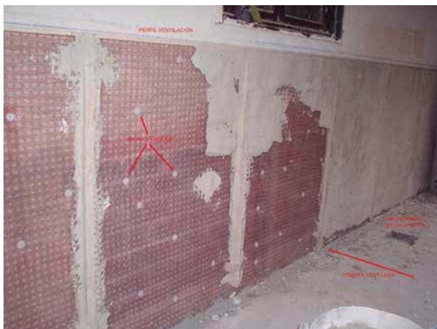
Fig. 11. Sistema de aislamiento de la pared para la reubicación de los azulejos. Lamina modular de PEAD con malla soldada. La parte inferior entre en la cámara de ventilación y la superior ventila a través de un perfil perforado.
