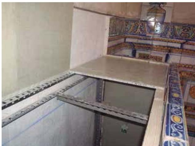
Fig. 16. Montaje autoportante del altar situado en el ángulo noroeste. Perfiles de acero inoxidable y tableros tipo sandwich de dos caras de fibra de vidrio y alma de celdilla de nido de abeja de aluminio.
