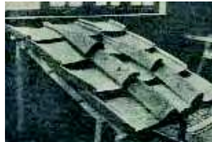
Muestra del tipo de cubierta con tégula e ímbrice de una casa romana.
