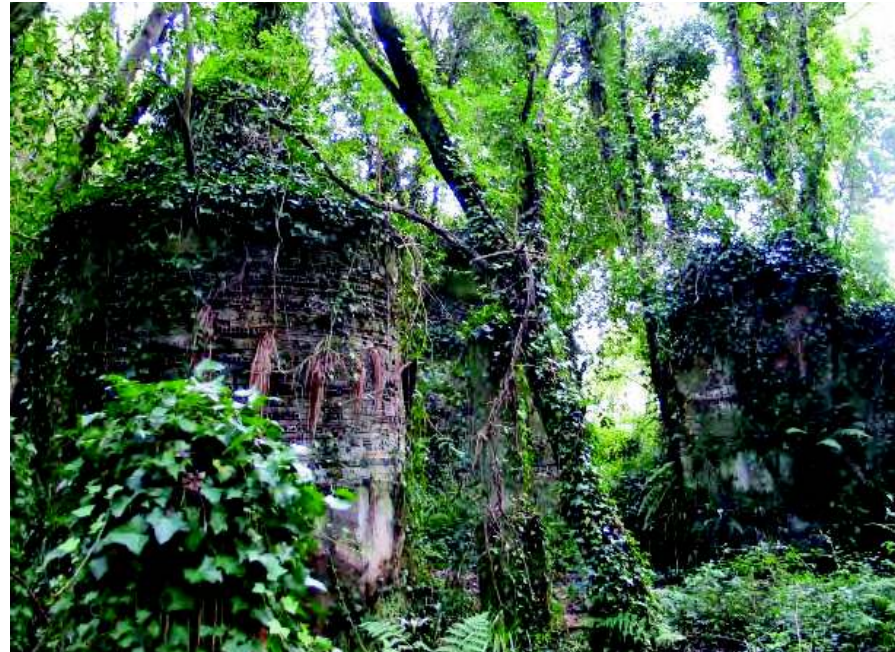
Dos hornos y restos de construcciones, rodeados de maleza.
