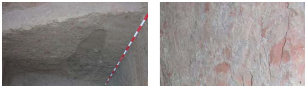
Fig. 2. Sección del depósito de arcillas de calle Pascual.
