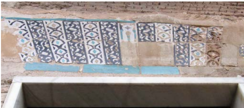
Fig. 19. Dintel en el acceso al patio del Generalife
