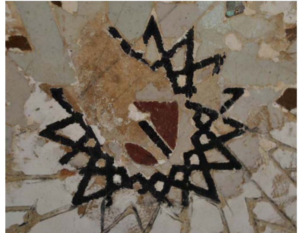
Fig. 23. Sino en el zócalo de la torre de la Cautiva, esquina sureste
