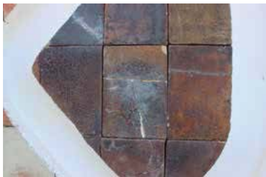
Fig. 5. En el mural de Rosa María Espí se han sellado las grietas de las piezas con cemento y silicona, dejando un halo blanquecino alrededor.
